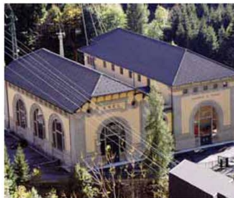
La centrale idroelettrica di Carona
