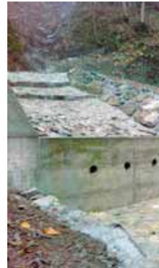
La Valle della Signora dopo i lavori
