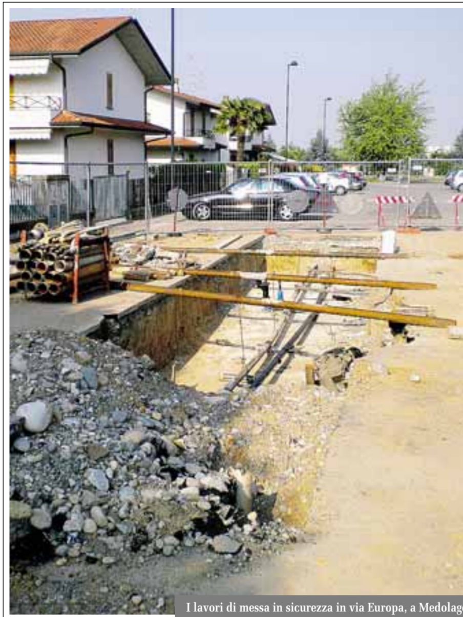
I lavori di messa in sicurezza in via Europa, a Medolago
